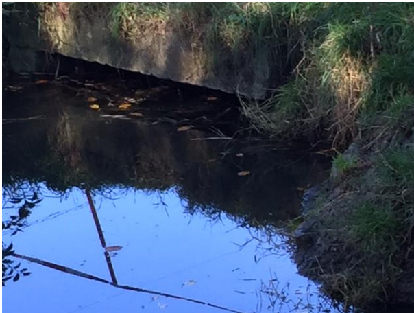
Einstauung, Einsicht vom rechten Ufer
