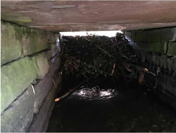
Sicht unter die Brücke, unterwassereitig
